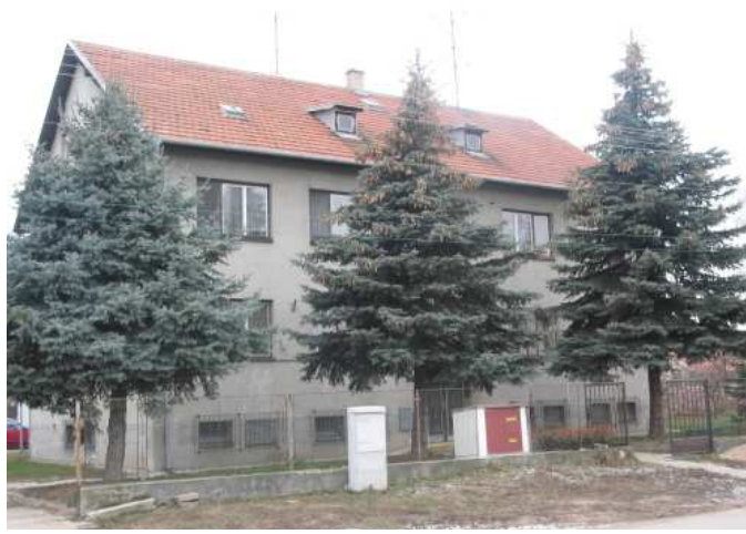
Budova OOP ČR Prosiměřice, č.p. 156
